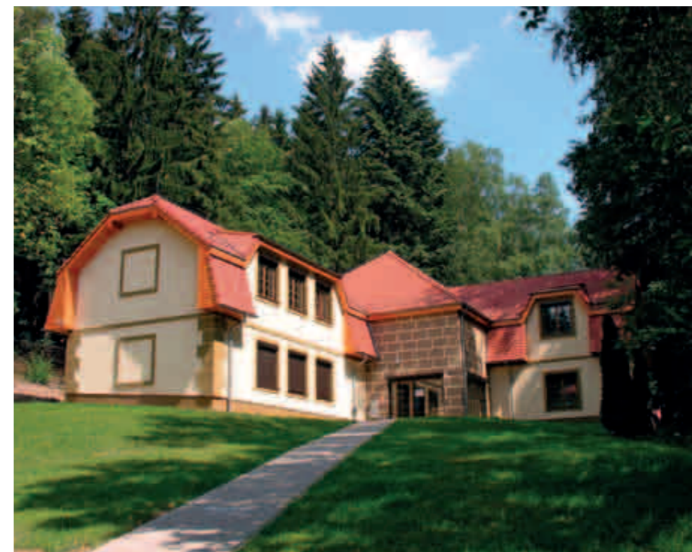
Fot. 4. Budynek Ekocentrum PNGS
