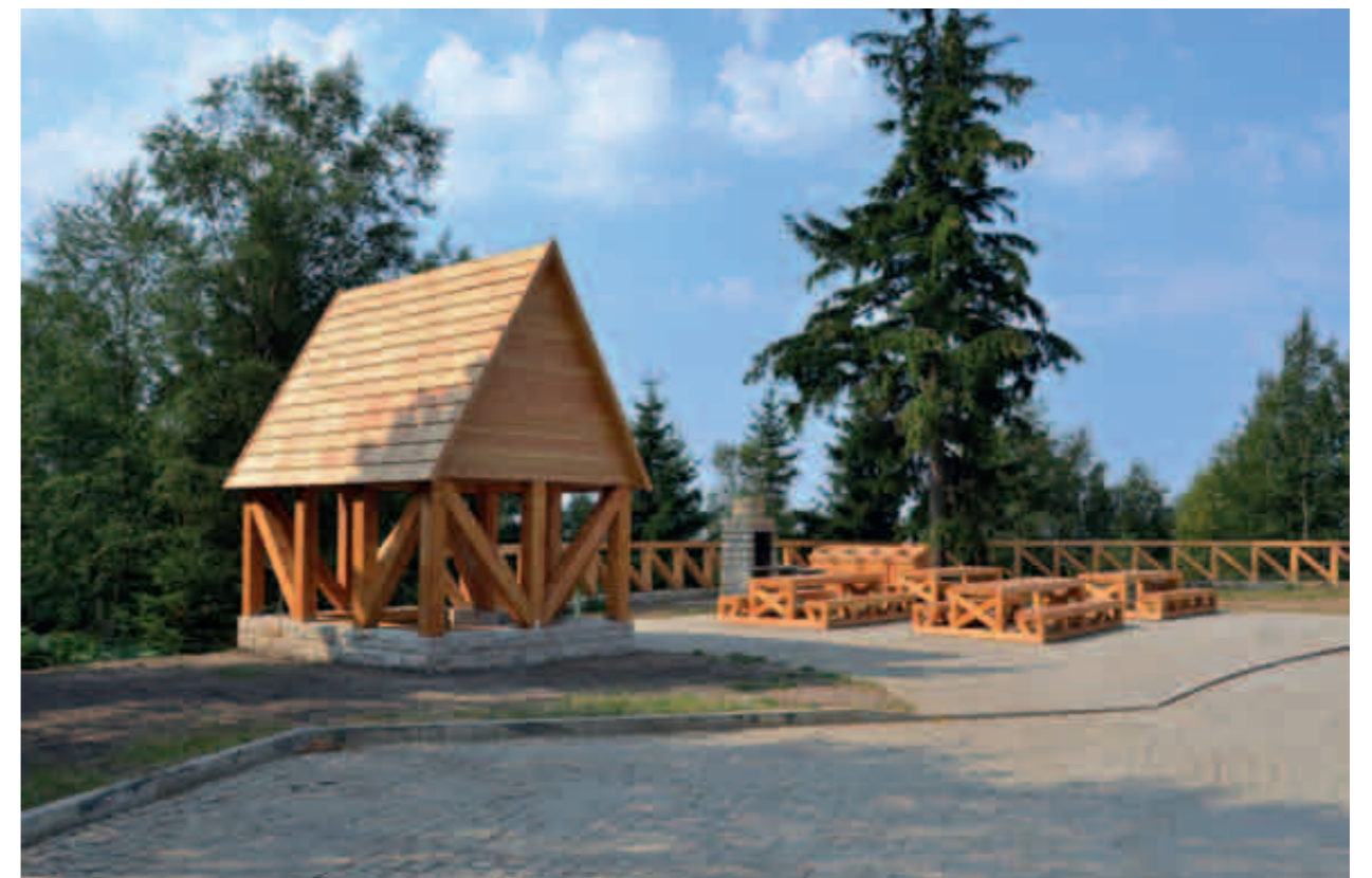
Fot. 4. Infrastruktura turystyczna na terenie PNGS
